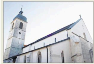
L'église Saint-Pierre souffre de l'humidité. L'installation d'un fil de cuivre devant empêcher ce problème, avant que les murs ne soient traités.
